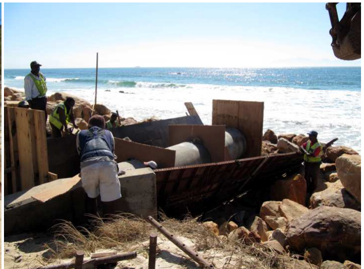
Stormwaterpype word nou dieper see-in gelê en reg rondom met beton gevul. Die skopgrawe help steeds. Foto's: Luca Lategan
