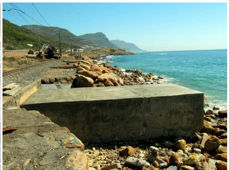
'n Uitlaat wat reeds sy beton beskerming het. Rondom die uitlaat sal dit steeds met klip gevul word. Foto's: Luca Lategan
